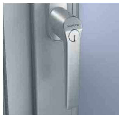
Abschließbare Griffe sichern die Schließfunktion des Flügels.
