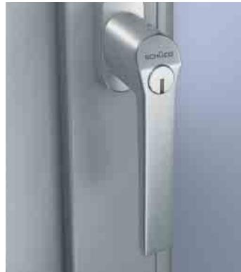
Abschließbare Griffe sichern die Schließfunktion des Flügels.
